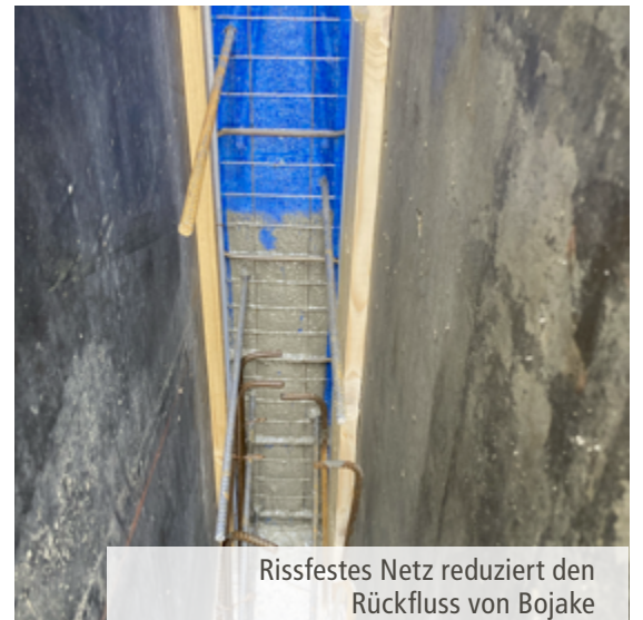
Auch bei Installationsdurchführungen kein Aufreißen des Netzes
