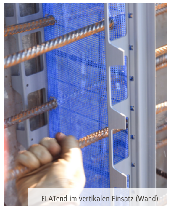
Rissfestes Netz reduziert den Rückfluss von Bojake
