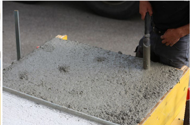
Figure 10 : a) Epreuve avant le bétonnage, b) Bétonnage de la première étape, c) Coffrage après le bétonnage de la première étape, d) Bétonnage de la deuxième étape.
