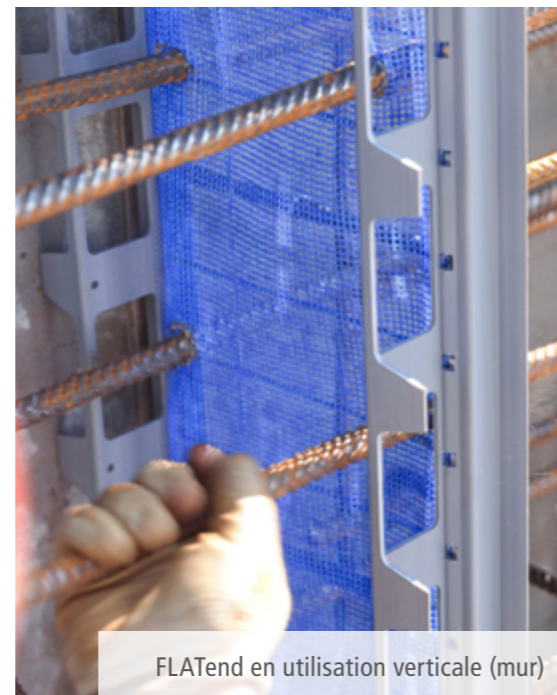
Le filet résistant aux déchirures réduit le reflux des boues.
