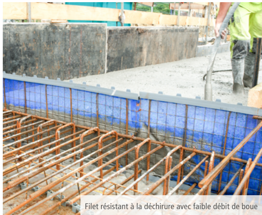
La construction robuste de l'élément empêche tout basculement.
